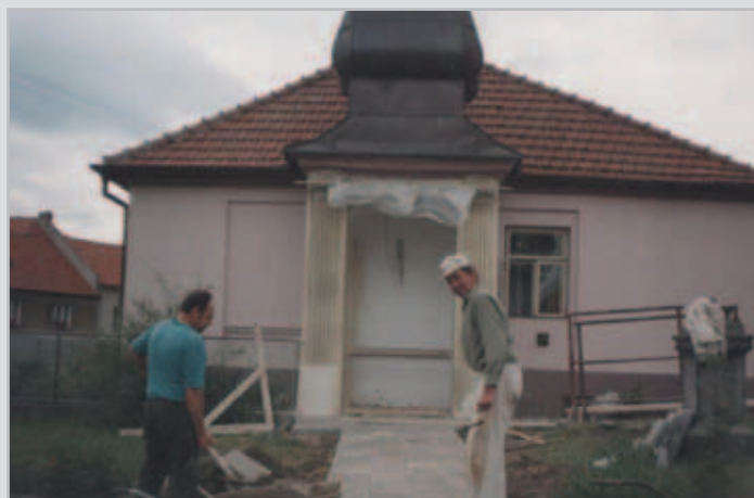
rekonstrukce kapličky na návsi a sochy sv. Jana Nepomuckého
